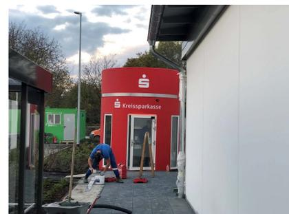
Die Selbstbedienungs-Pavillons der Firma Veloform sind extrem langlebig und stabil. Trotz massiver Rundkonstruktion aus stahlarmiertem Beton und hohem Gewicht, lässt sich der an einem Stück gefertigte Pavillon einfach aufstellen und gut umplatzieren. Der Pavillon kann sogar als Eventmodul eingesetzt werden.
